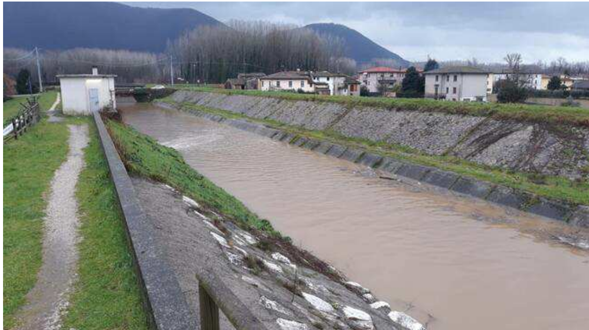
Realizzazione e manutenzione canali irrigui
