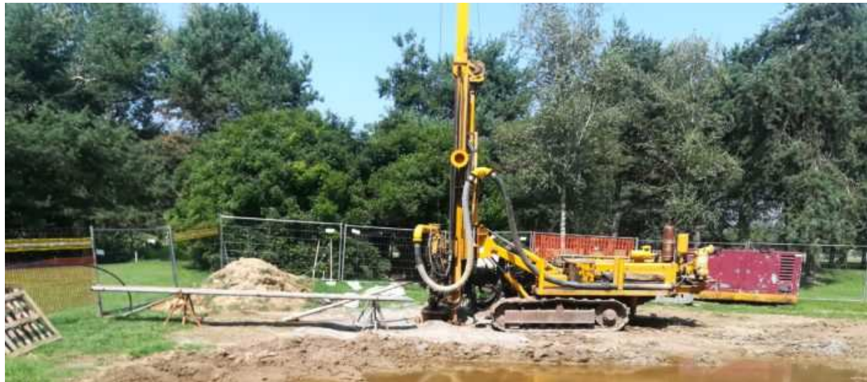
Realizzazione pozzi per l'irrigazione e Agriturismi
