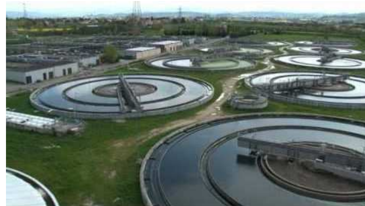
IMPIANTO SAN COLOMBANO SCANDICCI, DURATA 7 MIN
